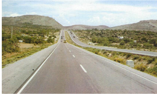
La carretera Querétaro-San Luis Potosí fue ampliada a cuatro carriles. Memorias SCT 1982-1988.
